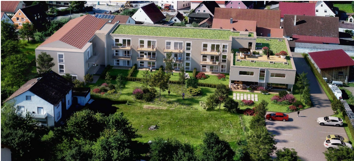
Bauprojekt „Wohnen für alle“ mit den Bauabschnitten I (links), II (Mitte) und III (rechts). Linkerhand führt die Weißenburger Straße vorbei.
